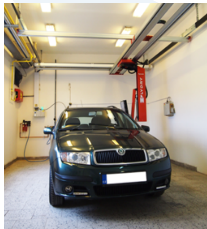
Přípravné stání se sušícím robotem Symach Flydry.
